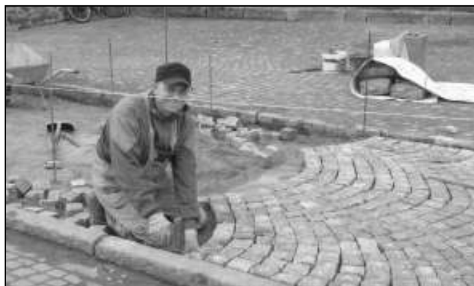
Fachowo układana granitowa kostka przy olsztyńskim zamku
