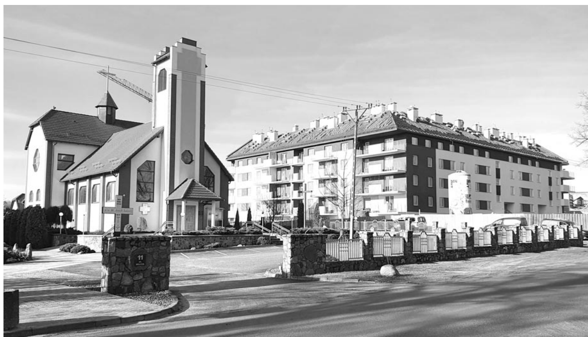
Pierwszy z budynków wielorodzinnych przy ul. Wilczej / fot. Robert Waraksa
