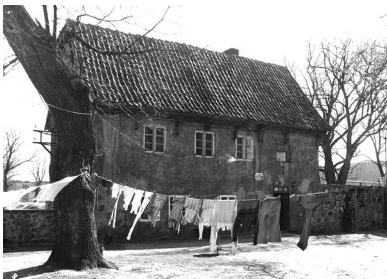
Dom Mrongowiusza przed remontem / fot. zbiory TPO
